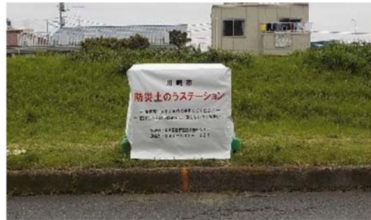
土のうステーション（かすみ堤）
